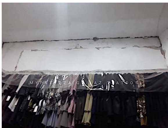
Εικόνες 3,4. Αποκόλληση τοιχοποιίας πλήρωσης από το περιβάλλον πλαίσιο οπλισμένου σκυροδέματος.
