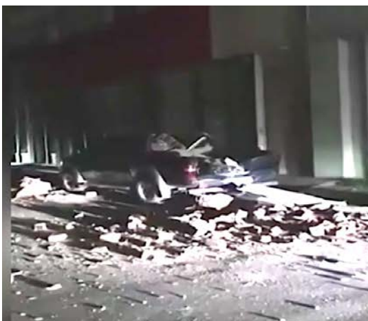
Εικόνες 5,6. Πτώση τοιχοποιιών από ορόφους σε δρόμο και αυτοκίνητο (πηγή, +PLUS.GR).
