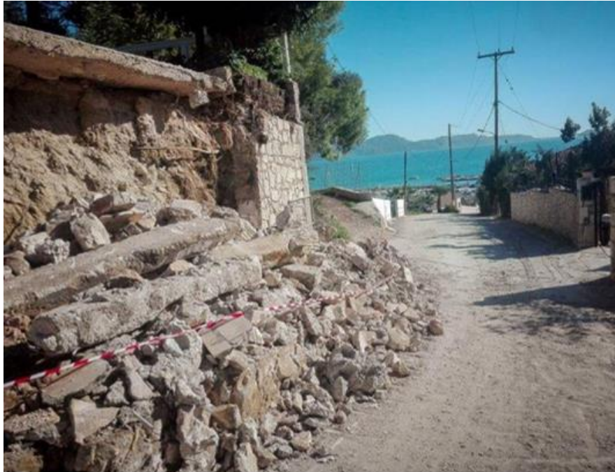
Εικόνα 9: Αστοχία τοίχου αντιστήριξης μετά τον σεισμό της Ζακύνθου (Πηγή: https://www.cnn.gr )
