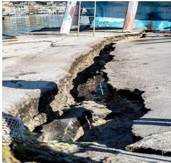
Εικόνα 2. Μετάθεση και στροφή των κρηπιδότοιχων (μπλόκια) στο λιμάνι της πόλης της Ζακύνθου
