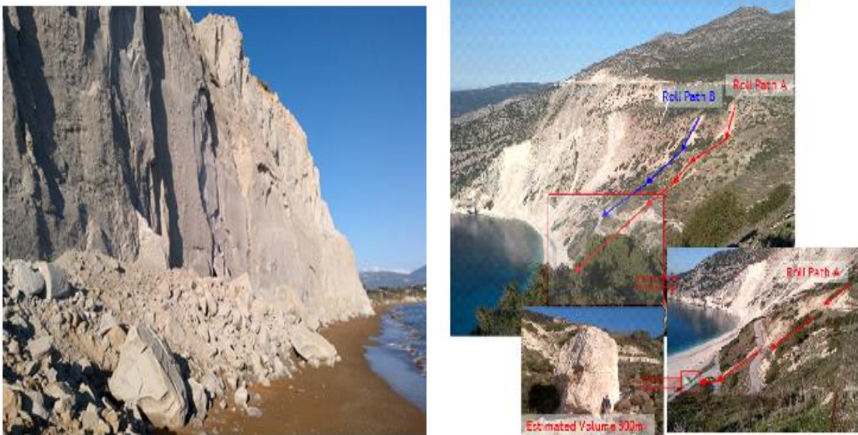
Εικόνα 8 (α) Κατολισθητικά φαινόμενα αμμωδών μαργαϊκών σχηματισμών στην παραλία και (β) Αποκόλληση ασβεστολιθικών τεμαχίων στην παραλία Μύρτος, μετά τους σεισμούς της Κεφαλονιάς (26/01/2104 και 03/02/2014)
