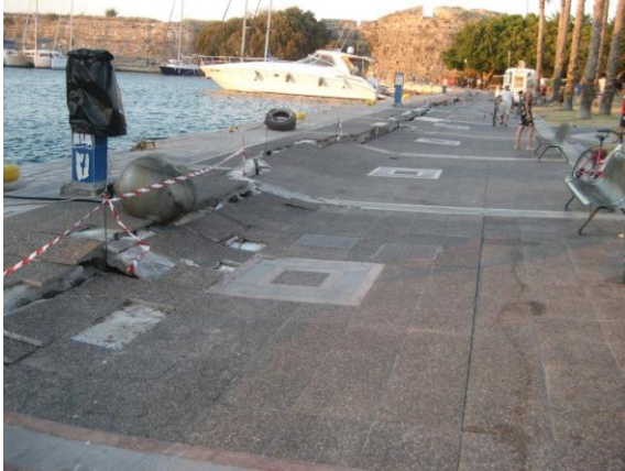
Εικόνα 5. Βλάβες/αστοχίες σε λιμενικές εγκαταστάσεις και κρηπιδότοιχους στην Κω μετά το σεισμό της 21ης Ιουλίου 2017
