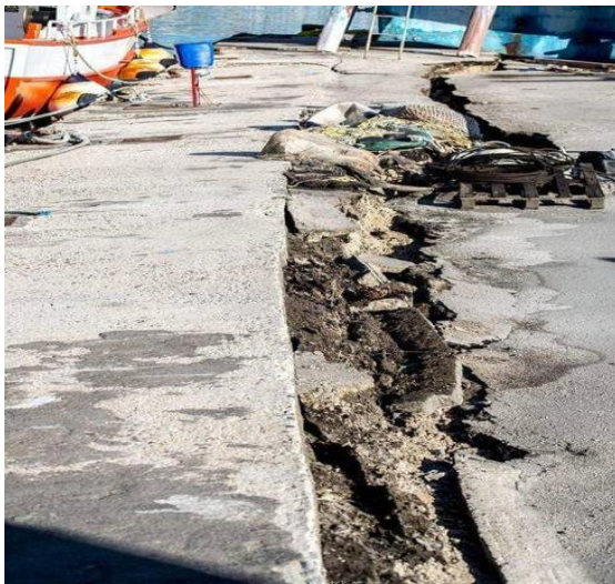
Εικόνα 2. Μετάθεση και στροφή των κρηπιδότοιχων (μπλόκια) στο λιμάνι της πόλης της Ζακύνθου
