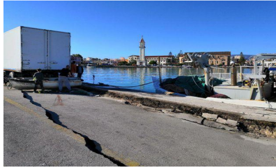
Εικόνα 1. Αστοχίες/βλάβες με την μορφή διαμήκων ρηγματώσεων στις προβλήτες με ταυτόχρονη καθίζηση του υλικού επίχωσης στο λιμάνι της πόλης της Ζακύνθου
