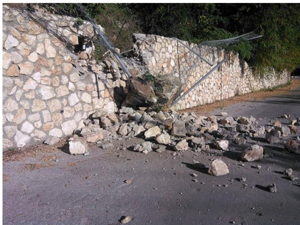
Εικόνα 10: Ενδεικτικές αστοχίες λιθόκτιστων τοίχων αντιστήριξης που καταγράφηκαν μετά τους σειμούς Λευκάδας (2015) (αριστερά) και Κεφαλονιάς (2014) (δεξιά)
