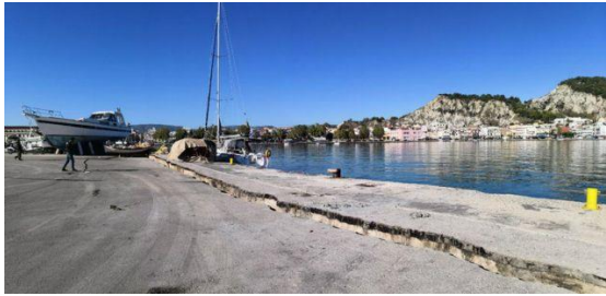
Εικόνα 1. Αστοχίες/βλάβες με την μορφή διαμήκων ρηγματώσεων στις προβλήτες με ταυτόχρονη καθίζηση του υλικού επίχωσης στο λιμάνι της πόλης της Ζακύνθου
