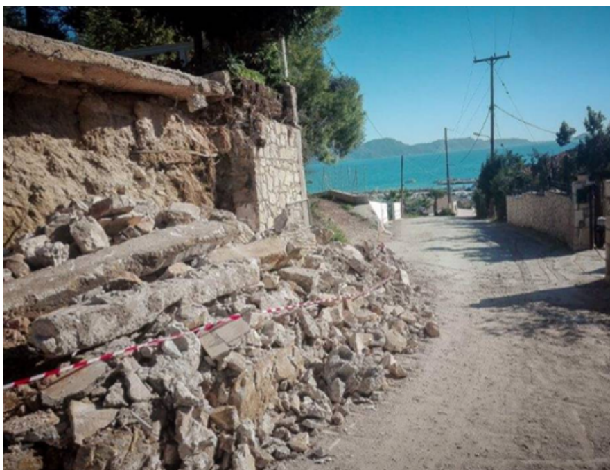
Εικόνα 10: Αστοχία τοίχου αντιστήριξης μετά τον σεισμό της Ζακύνθου (Πηγή: https://www.cnn.gr )
