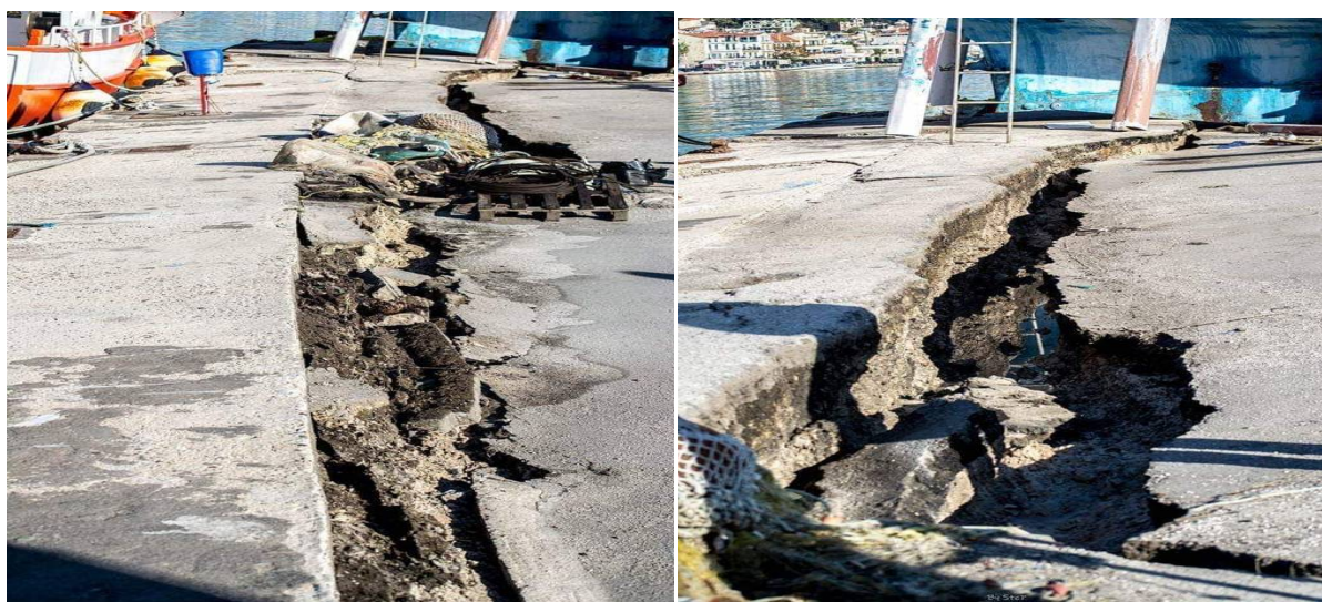
Εικόνα 2. Μετάθεση και στροφή των κρηπιδότοιχων (μπλόκια) στο λιμάνι της πόλης της Ζακύνθου
