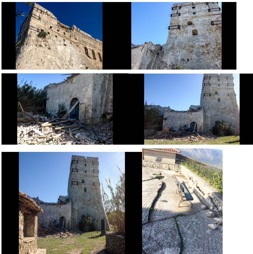
Εικόνα 14. Οι βλάβες στο Καστρομονάστηρο των Στροφάδων
