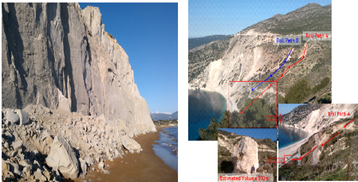
Εικόνα 9 (α) Κατολισθητικά φαινόμενα αμμωδών μαργαϊκών σχηματισμών στην παραλία Ξι και (β) Αποκόλληση ασβεστολιθικών τεμαχίων στην παραλία Μύρτος, μετά τους σεισμούς της Κεφαλονιάς (26/01/2104 και 03/02/2014)
