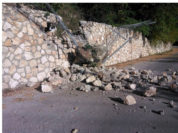
Εικόνα 11: Ενδεικτικές αστοχίες λιθόκτιστων τοίχων αντιστήριξης που καταγράφηκαν μετά τους σεισμούς Λευκάδας (2015) (αριστερά) και Κεφαλονιάς (2014) (δεξιά)
