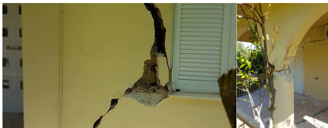
Εικόνα 12. Παραδοσιακό κτίσμα στη χώρα της Ζακύνθου.
