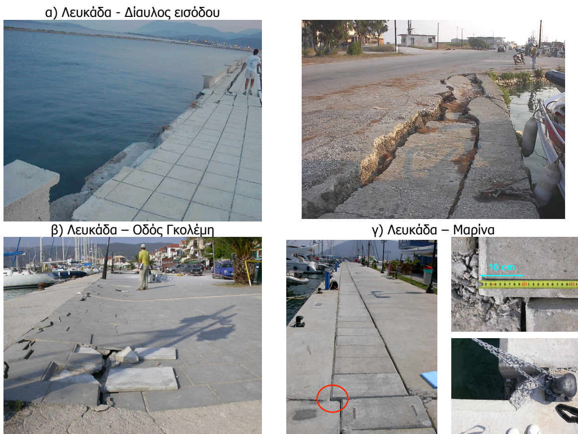
Εικόνα 4. Βλάβες/αστοχίες σε λιμενικές εγκαταστάσεις και κρηπιδότοιχους σε διάφορες θέσεις (διάυλο εισόδου, λιμάνι, Μαρίνα) στη Λευκάδα μετά το σεισμό της 14ης Αυγούστου 2003.
