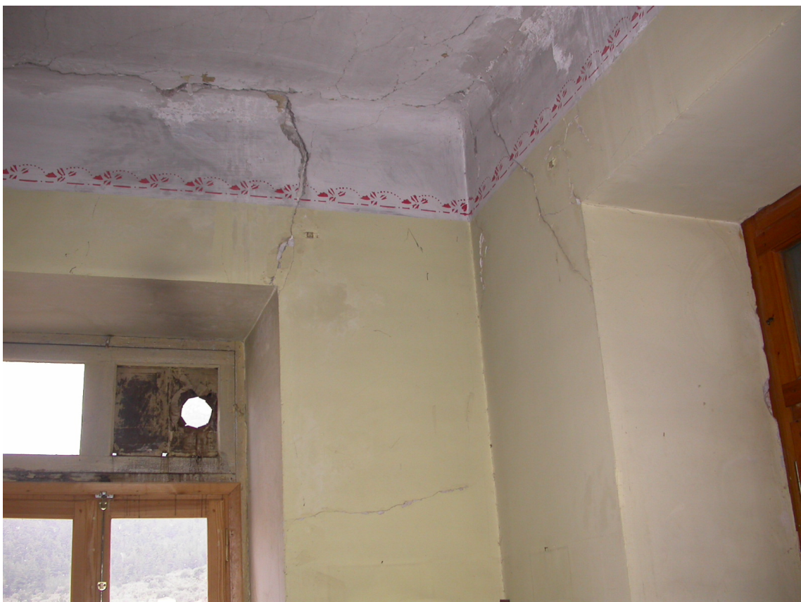
Φωτ.18. Ανάπτυξη ρηγματώσεων στην λιθόκτιστη τοιχοποιία του διατηρητέο διώροφου αρχοντικού της φωτ.17, στο Λεωνίδιο.
