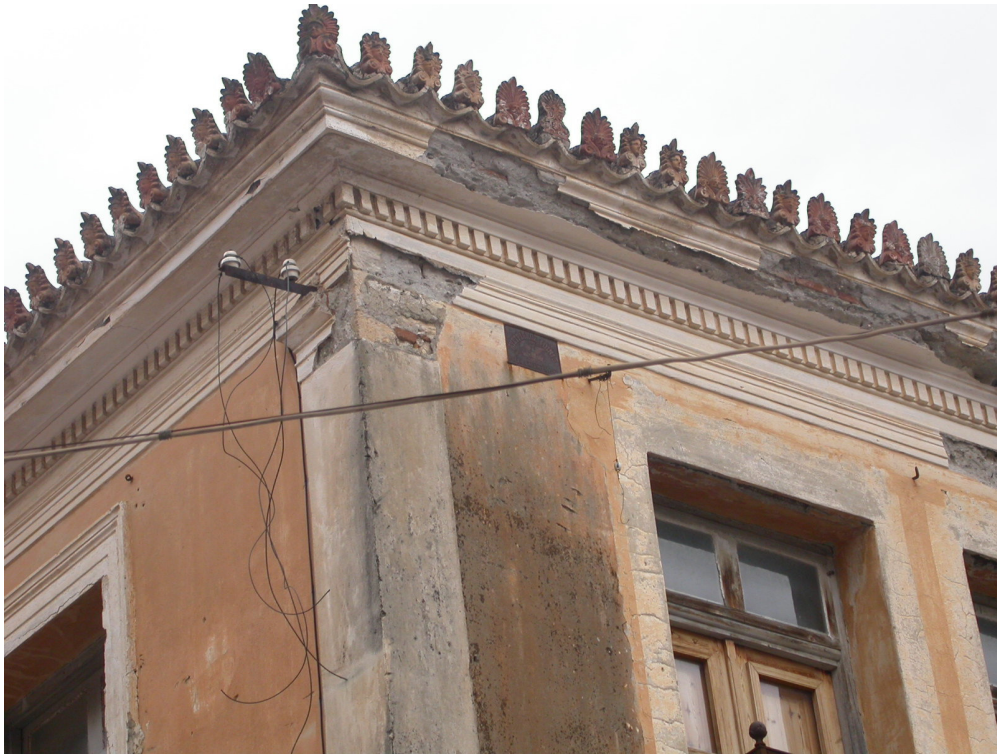
Φωτ.17. Πτώση σοφάδων και αετωμάτων σε διατηρητέο διώροφο αρχοντικό στο Λεωνίδιο.
