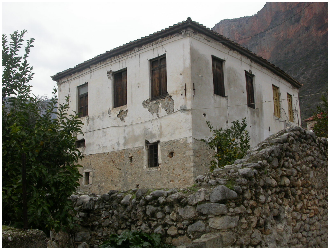
Φωτ.8. Ανάπτυξη ρηγματώσεων σε παλιό λιθόκτιστο κτίριο στο Λεωνίδιο..
