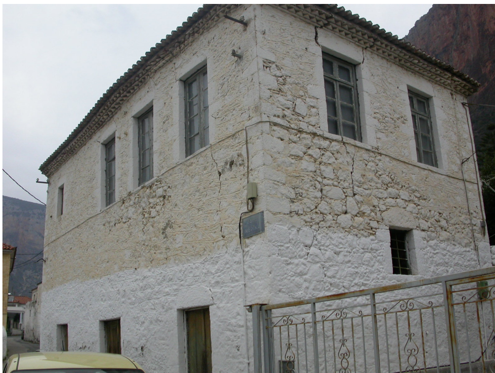
Φωτ.7. Ανάπτυξη ρηγματώσεων σε παλιό λιθόκτιστο κτίριο στο Λεωνίδιο..
