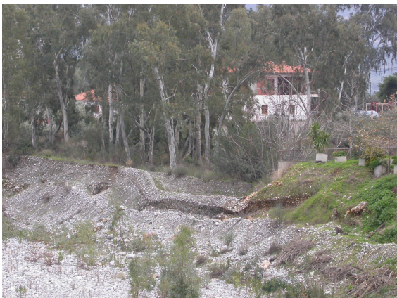
Φωτ.3, & 4. Μετατόπιση τμημάτων «ζαρζανέτ» στις όχθες του ξεροποτάμου Δαφνώνας που διασχίζει το Λεωνίδιο.
