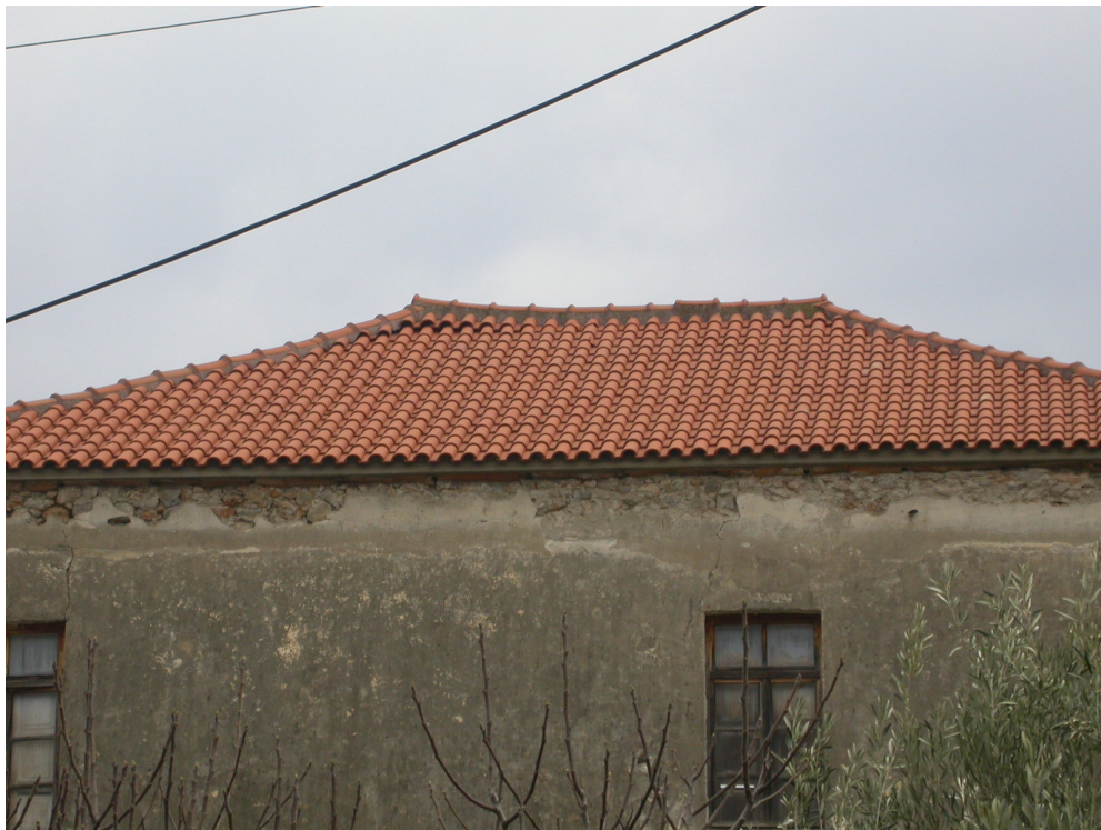
Φωτ.12. Πτώση σοφάδων και αστοχία κεραμιδιών σε παλιό λιθόκτιστο κτίριο στο Λεωνίδιο.
