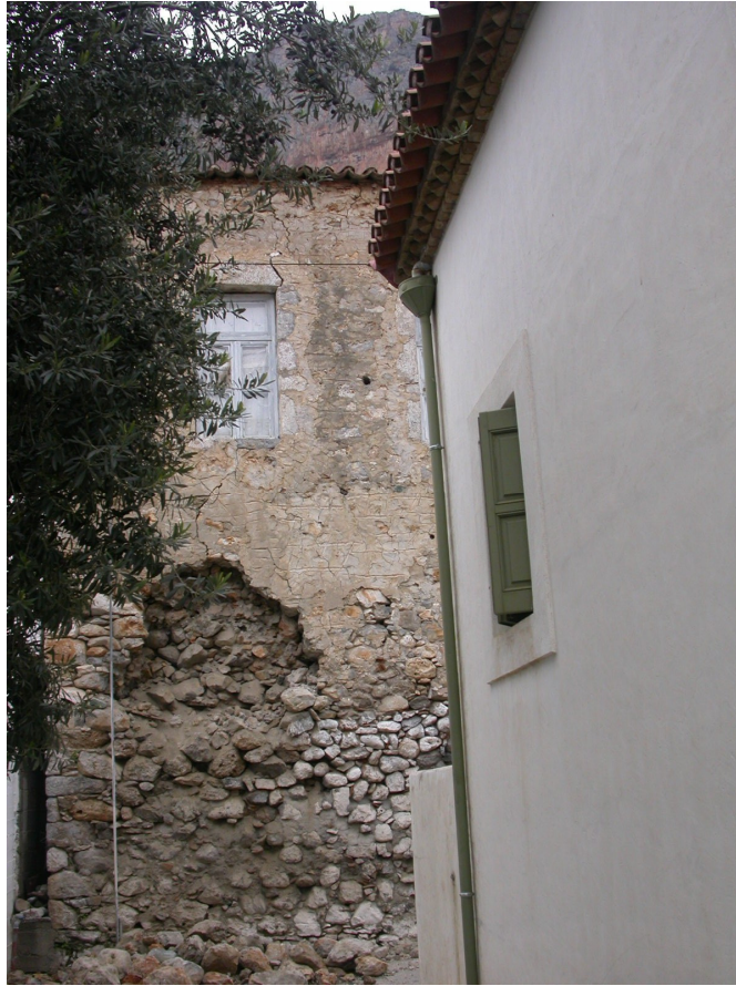
Φωτ.11. Τμηματική πτώση φέροντα τοίχου σε λιθόκτιστο κτίριο κατασκευής πριν το 1900 στο Λεωνίδιο.
