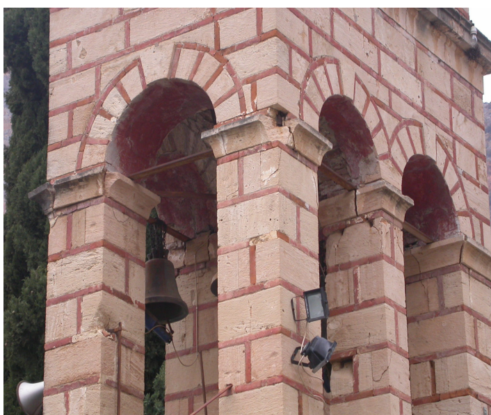
Φωτ. 13,14. Βλάβη στο λιθόκτιστο καμπαναριό του Ι.Ν. Αγ. Αικατερίνης του Λεωνιδίου.
