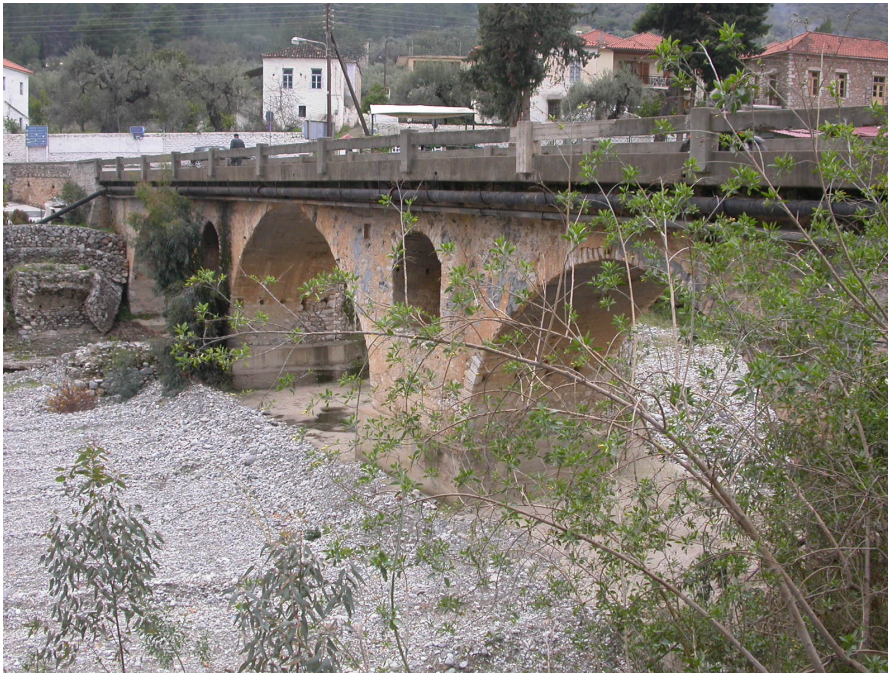
Φωτ. 19. Λιθόκτιστη Γέφυρα στο Λεωνίδιο , επί του ξεροποτάμου Δαφνώνα, κατασκευής 1830, που δεν εμφάνισε βλάβες.
