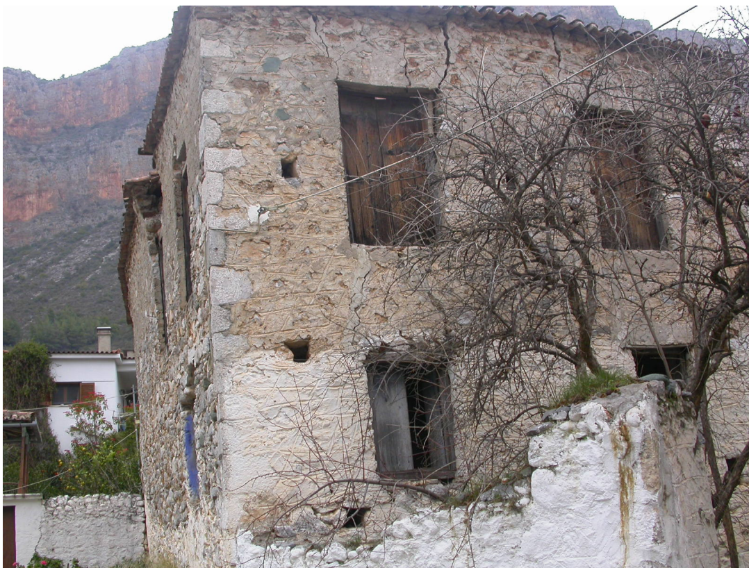
Φωτ.9. Ανάπτυξη ρηγματώσεων σε παλιό εγκατελειμένο λιθόκτιστο κτίριο στο Λεωνίδιο..
