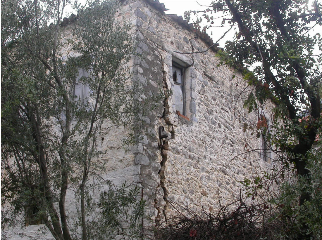
Φωτ.5. Αστοχία λιθόκτιστου κτιρίου (κατασκευής πριν το 1880) στο Λεωνίδιο με εμφάνιση έντονης κατακόρυφης ρωγμής. Η ξύλινη στέγη κατέρρευσε (Φωτ.6).
