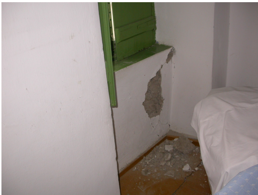
Φωτ.10. Πτώση λιθοσωμάτων σε λιθόκτιστο παλιό κτίριο στο Λεωνίδιο..
