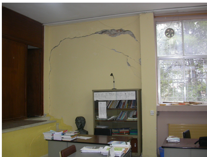
Φωτ. 20. Διάνοιξη προϋπάρχουσας ρηγματώσης στο Γυμνάσιο-Λύκειο του Λεωνιδίου.
