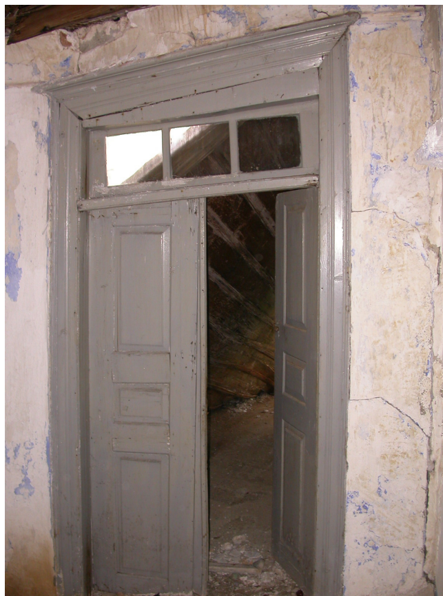
Φωτ.6. Αστοχία λιθόκτιστου κτιρίου (κατασκευής πριν το 1880) όπου η ξύλινη στέγη κατέρρευσε, στο Λεωνίδιο.
