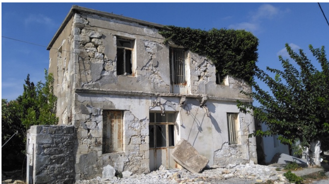
Εικόνα 6.8. Κτήριο με λιθοδομή από επεξεργασμένες πέτρες και επιμελημένη δόμηση στο Αλάγνι. Παρατηρούνται ρηγματώσεις σε οριζόντιους και κατακόρυφους αρμούς μεταξύ των λίθων. Δεν δημιουργήθηκαν μερικές ή τοπικές καταρρεύσεις λιθοδομών.
