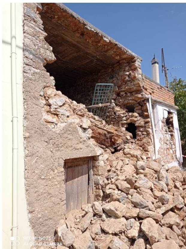
Εικόνα 6.3. Μερική κατάρρευση λιθοδομής με ακανόνιστες πέτρες στον οικισμό Σαμπάς.
