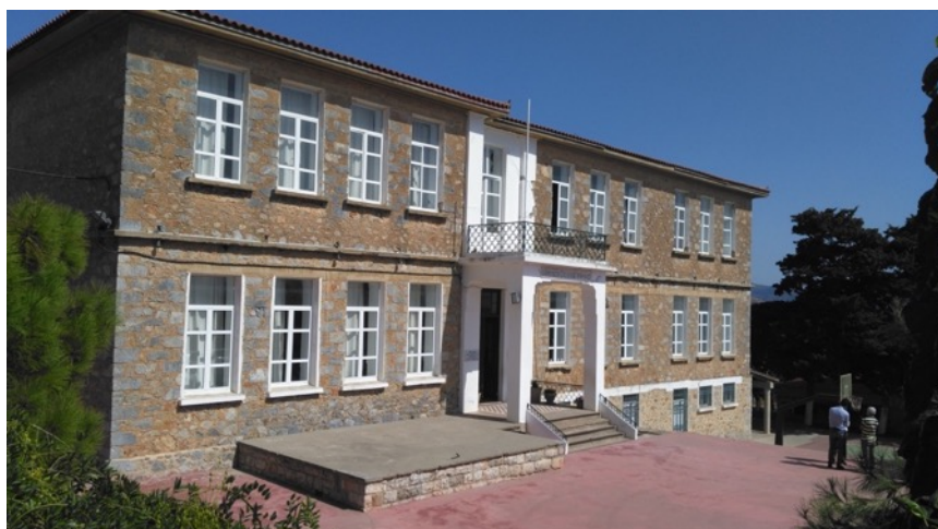
Εικόνα 6.9. Δημοτικό σχολείο στο Θραψανό με καλοδομημένες λιθοδομές. Αναπτύχθηκε ρηγματώση η οποία δεν δημιούργησε καταρρεύσεις.
