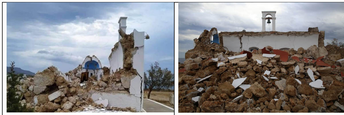
Σχήμα 5. Καταστροφή της εκκλησίας του Αγίου Νικολάου (Δεξιά Πριν το σεισμό & Αριστερά μετά)
