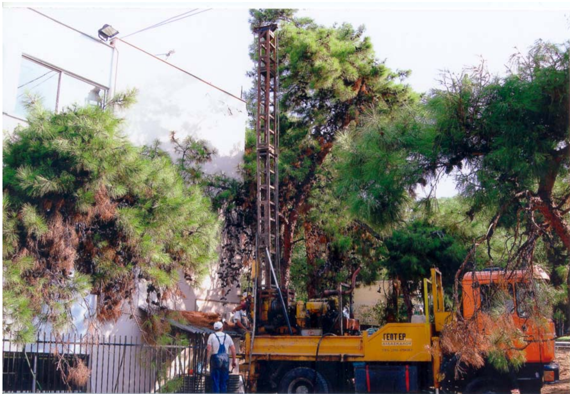
ΓΕΩΤΡΗΣΗ Γ3 - ΘΕΣΗ : ΣΕΙΣΜΟΛΟΓΙΚΟ ΙΝΣΤΙΤΟΥΤΟ ΘΕΣΣΑΛΟΝΙΚΗΣ ΕΡΓΟ : ΕΚΤΕΛΕΣΗ ΔΕΙΓΜΑΤΟΛΗΠΤΙΚΩΝ ΓΕΩΤΡΗΣΕΩΝ ΓΙΑ ΕΓΚΑΤΑΣΤΑΣΗ ΤΡΙΑΞΟΝΙΚΩΝ ΕΠΙΤΑΧΥΝΣΙΟΜΕΤΡΩΝ ΕΝΤΟΣ ΑΥΤΩΝ
