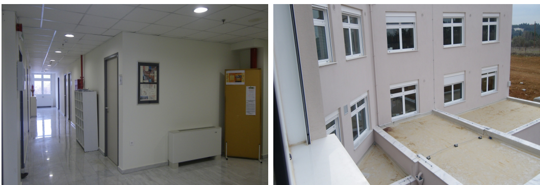
Κτίριο ΟΑΣΠ-ΙΤΣΑΚ (Ιανουάριος 2014)
