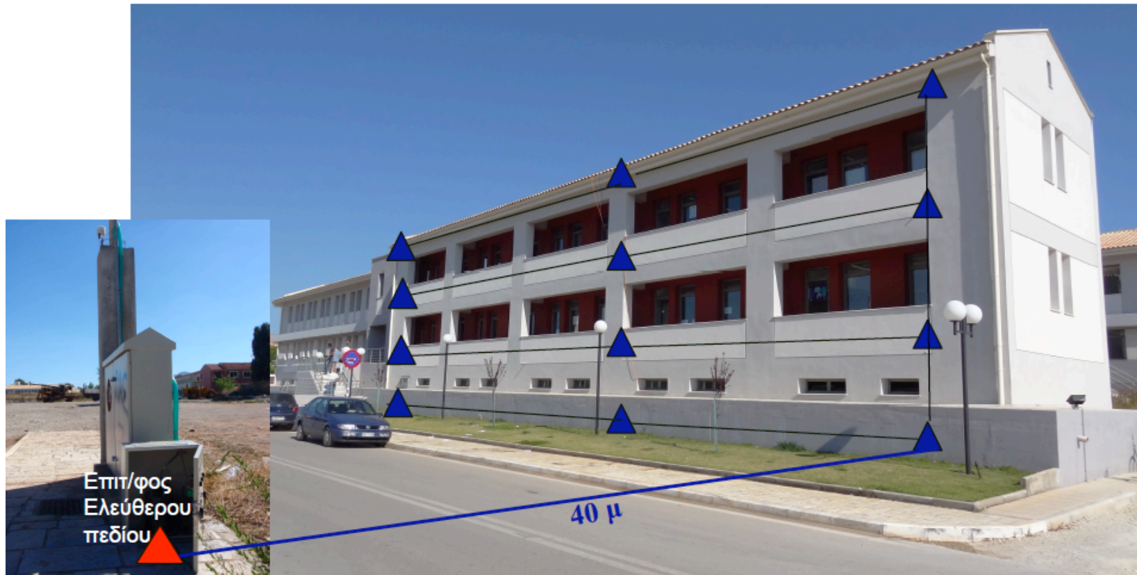
Ενοργάνωση Κρίσιμων Κτιρίων - Κινητά Μετρητικά Συστήματα : Διοικητήριο Λευκάδας
