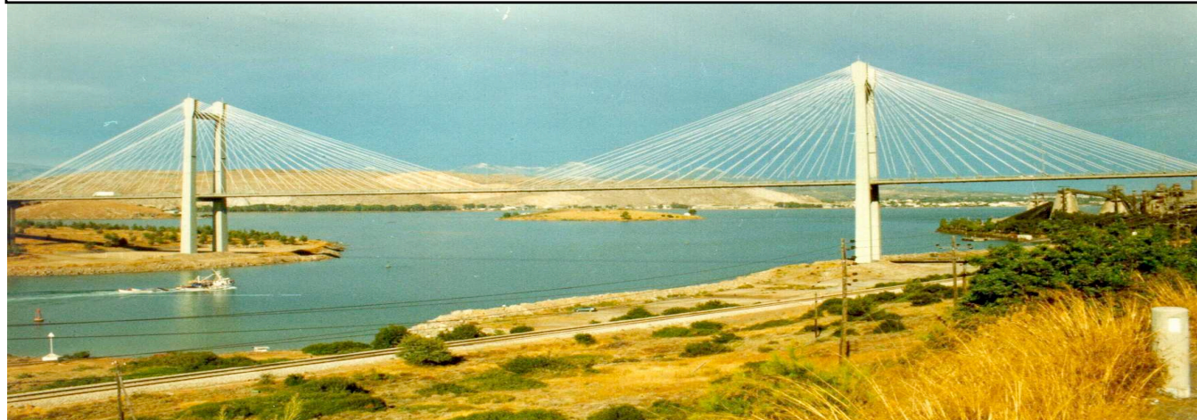
Ενοργάνωση Έργων Υποδομών: Υψηλή Γέφυρα Χαλκίδας
