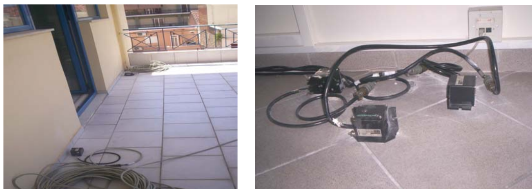
Σχήμα.3.3: Τοποθέτηση επιταχυνσιομέτρων επί του κτιρίου στέγαση του ΤΕΕ στην Πάτρα.
