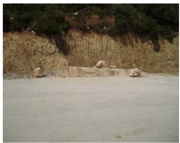
Φωτ. 2.3. Χωριό Πόρτες: γενική άποψη των ασβεστολιθικών πετρωμάτων των φυσικών πρανών (αριστερά) και των τμημάτων τους (<0.5μ 3 ) που ανατράπηκαν (δεξιά)
