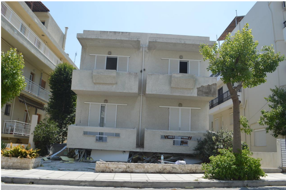
Εικόνες 31 32. Οικοδομή στην οδό Αρσενίου στην πόλη της Κω. Άνω: άποψη πριν τον σεισμό και Κάτω: αστοχία του ισόγειου μετά τον σεισμό της 21 ης Ιουλίου.
