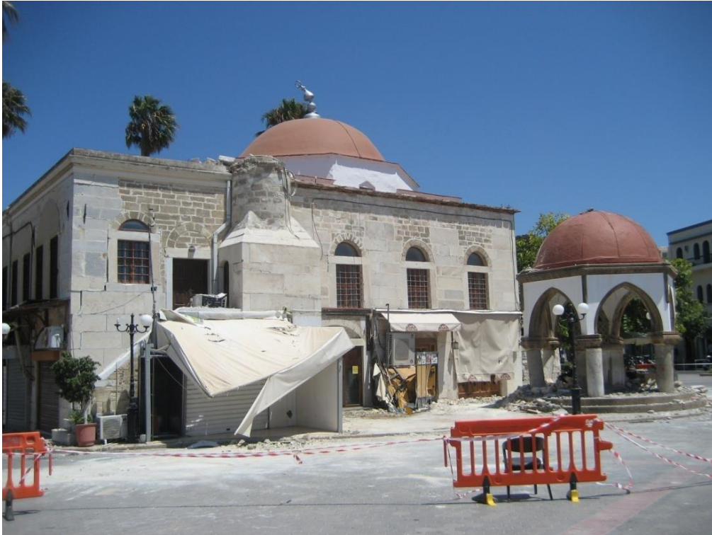
Εικόνα 13. Αστοχία Μιναρέ και τοπικές αστοχίες τζαμιού στην εμπορική πλατεία της Κω
