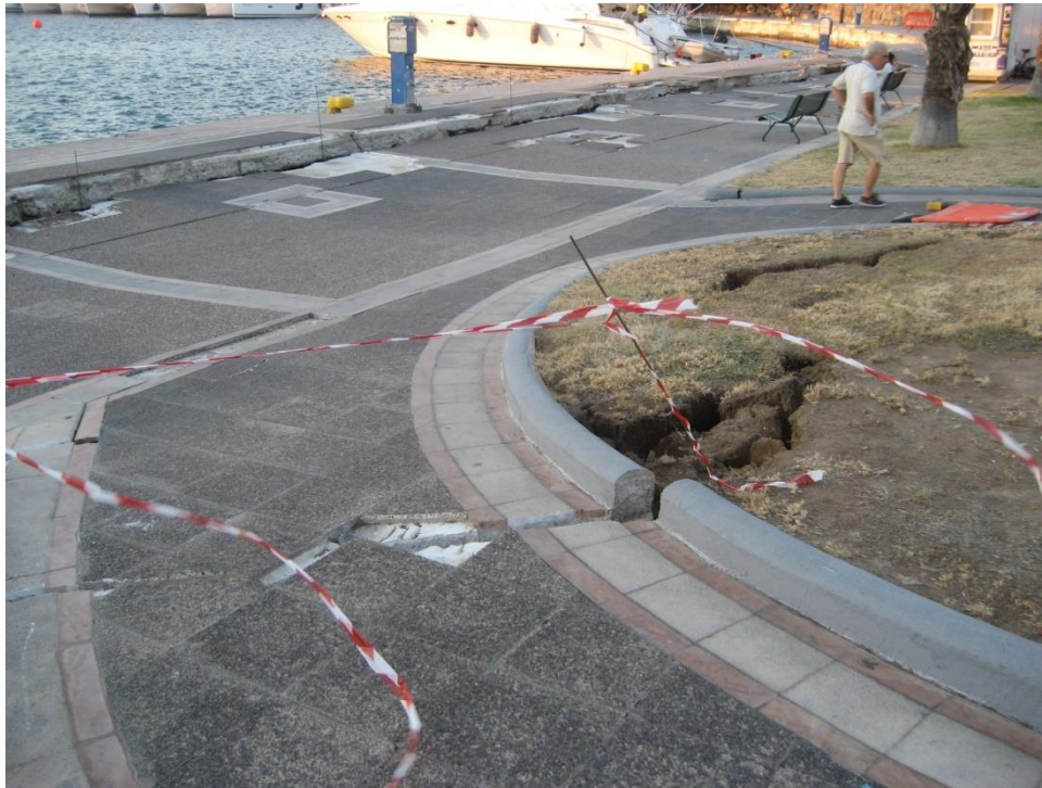
Εικόνα 5. Αποψη από την μαρίνα της Κω. Πίσω μέρος της περιοχής με καθιζήσεις όπου παρατηρείται ήπια κλίση
