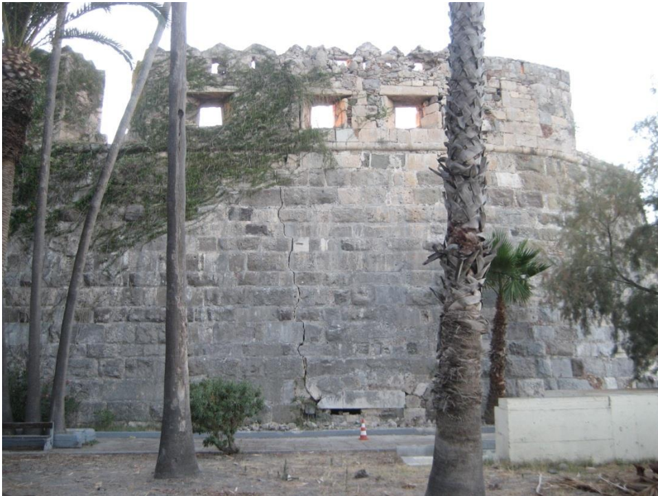
Εικόνα 8. Ρηγμάτωση σε τείχος του κάστρου στην πόλη της Κω
