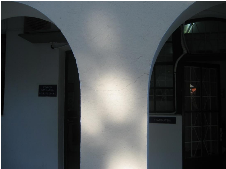
Εικόνα 27. Διάνοιξη αρμού μεταξύ δύο κτιρίων από οπλισμένο σκυρόδεμα
