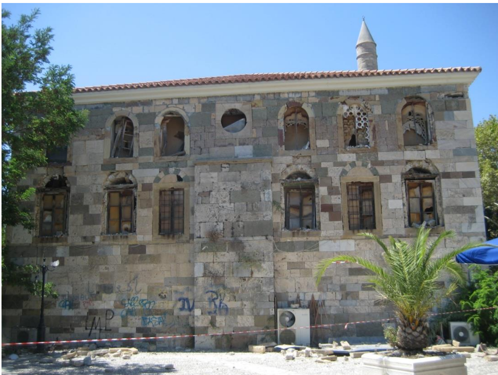
Εικόνα 16. Αστοχίες σε γεμίματα παραθύρων
