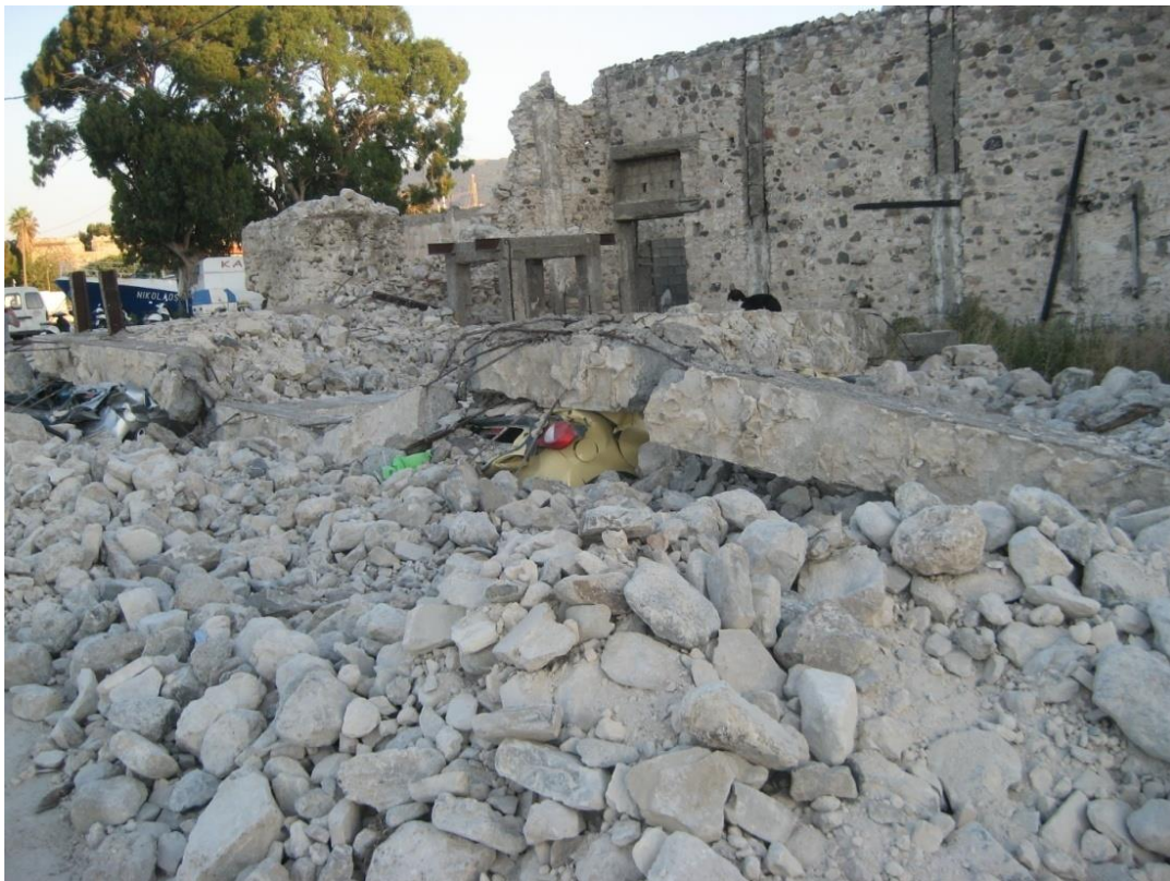
Εικόνες 25, 26. Αστοχία κτιρίου από λιθοδομή με στοιχεία σκυροδέματος στην πόλη της Κω
