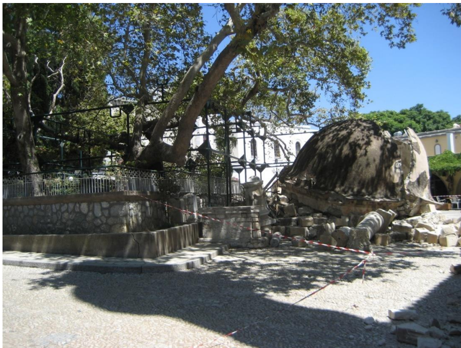
Εικόνα 18. Αστοχία κατασκευής στην πλατεία του πλάτανου του Ιπποκράτη
