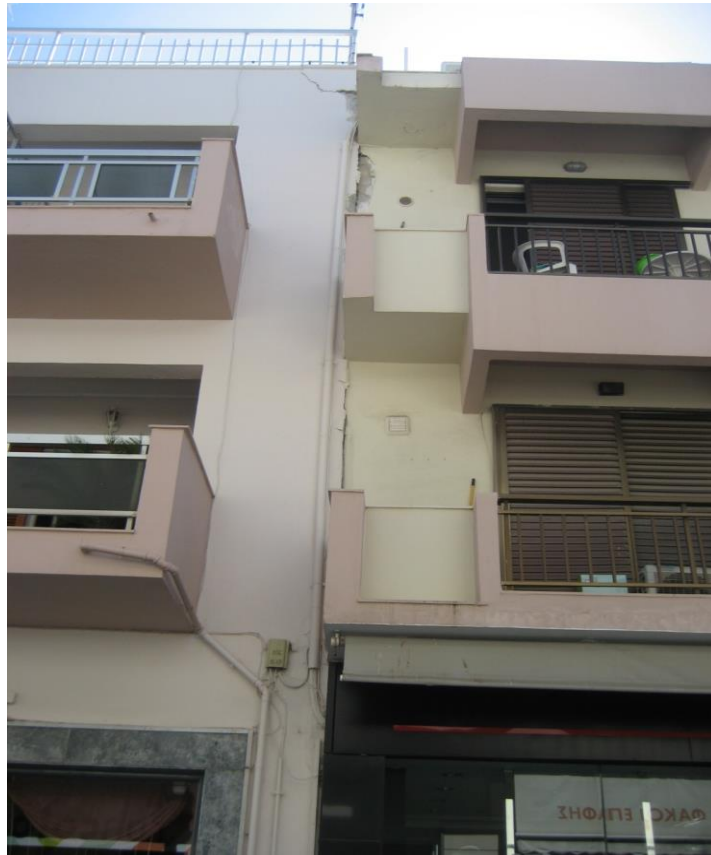
Εικόνα 27. Διάνοιξη αρμού μεταξύ δύο κτιρίων από οπλισμένο σκυρόδεμα
