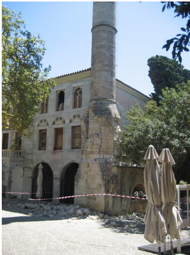
Εικόνες 34, 35. Απόκριση μιναρέ κατά τους σεισμούς 1933 και 2017. Εμφάνιση τοπικής αστοχίας κατά τον σεισμό του 2017.
