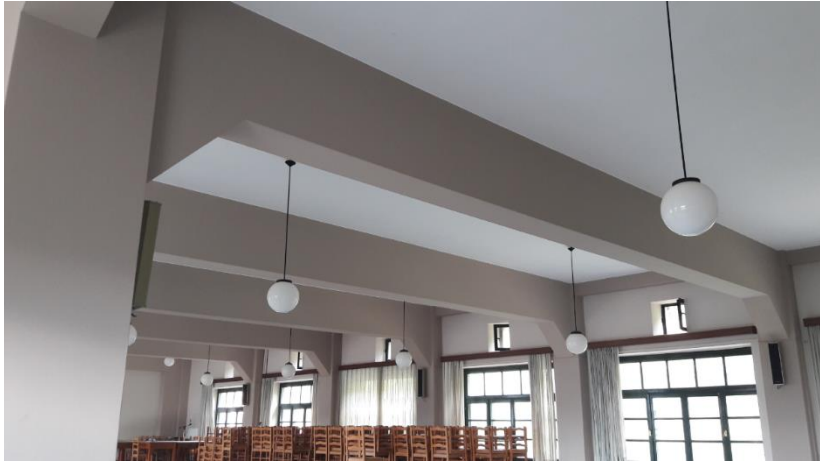
Εικόνα 7. Εσωτερικό παρακείμενου ανεξάρτητου κατασκευής 1960 - 1970 της Μονής Βελλάς το οποίο παρέμεινε πρακτικά άθικτο από τον σεισμό (κοντά στο χωριό Καλπάκι)
