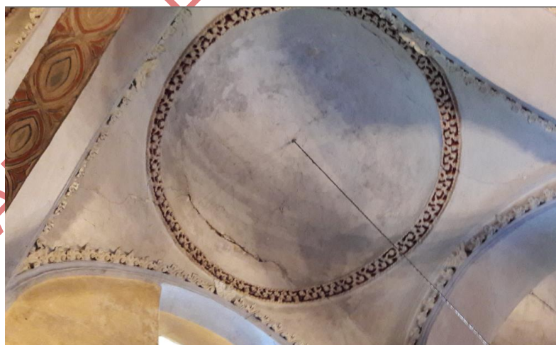
Εικόνα 4. Αστοχία τρούλου και εσωτερικών καμάρων ναού Αγ. Αθανάσιου (χωριό Κάτω Πεδινά)
