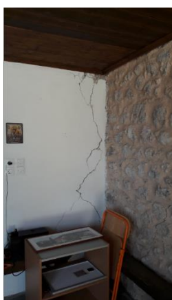
Εικόνα 3. Εκτεταμένες ρηγματώσεις και πλήρεις καταρεύσεις τοίχων λιθοδομής στο μοναστήρι της Παναγίας (χωριό Ασπράγγελοι)
