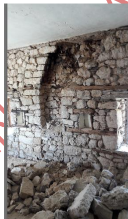
Εικόνα 3. Εκτεταμένες ρηγματώσεις και πλήρεις καταρεύσεις τοίχων λιθοδομής στο μοναστήρι της Παναγίας (χωριό Ασπράγγελοι)
