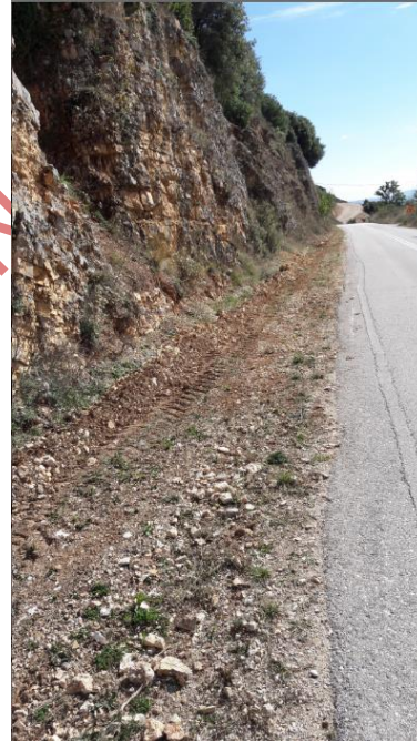
Εικόνα 1(β) Αποκατάσταση υλικών κατολίπωσης (Δρόμος Ιωάννινα - Ζίτσα)
