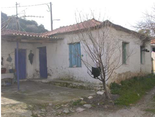
Φωτ. 38,39. Οικισμός Χρυσοκελαριά Δήμου Κορώνης. Ρηγματώσεις σε μονώροφο κτίριο από τοιχοποιία.
