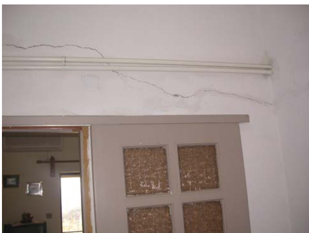
Φωτ. 34,35. Επιδείνωση προϋπαρχόντων ρηγματώσεων σε διαχωριστικούς τοίχους σε μονώροφο κτίριο από ο/σ στο Καλοχώρι.
