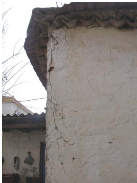
Φωτ. 42,43. Οικισμός Χρυσοκελαριά Δήμου Κορώνης. Ρηγματώσεις σε μονώροφο κτίριο από τοιχοποιία.
