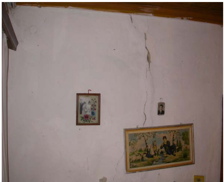
Φωτ.13,14. Πτώση σοφάδων και προυπάρχουσα ρηγμάτωση τοιχοποιίας στην Κορώνη.
