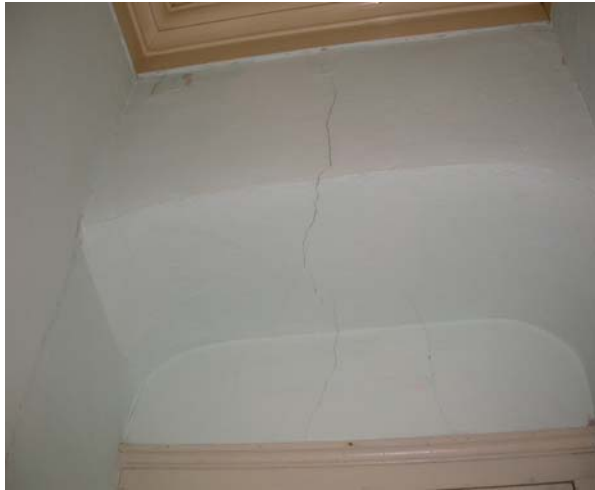
Φωτ.17,18. Αρχοντικό στην Κορώνη. Εσωτερικές ρηγματώσεις στην τοιχοποιία.
