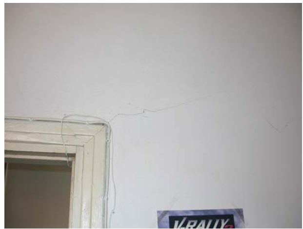
Φωτ.28,29. Οικισμός Αγ. Ανδρέας Δήμου Αίτπειας. Ρηγματώσεις σε δώροφο κτίριο από τοιχοποιία.
