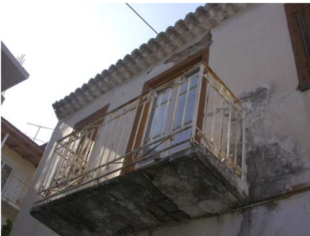
Φωτ.11,12. Πτώση σοφάδων σε διώροφο κτίριο στην Κορώνη.
