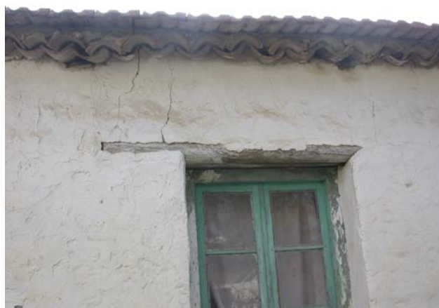
Φωτ. 40,41. Οικισμός Χρυσοκελαριά Δήμου Κορώνης. Ρηγματώσεις σε μονώροφο κτίριο από τοιχοποιία.
