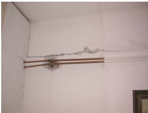
Φωτ. 32,33. Επιδείνωση προϋπαρχόντων ρηγματώσεων σε διαχωριστικούς τοίχους σε μονώροφο κτίριο από ο/σ στο Καλοχώρι.
