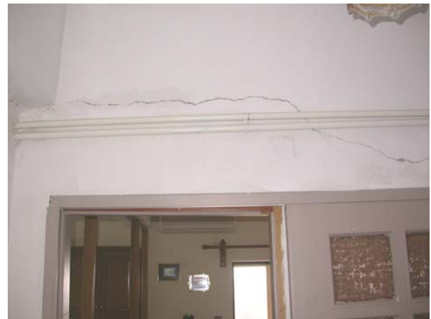
Φωτ.30,31. Επιδείνωση προϋπαρχόντων ρηγματώσεων σε διαχωριστικούς τοίχους σε μονώροφο κτίριο από ο/σ στο Καλοχώρι.
