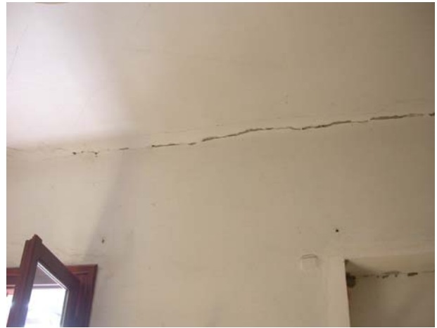
Φωτ.26,27. Οικισμός Αγ. Ανδρέας Δήμου Αίτπειας. Ρηγματώσεις σε δώροφο κτίριο από τοιχοποιία.
