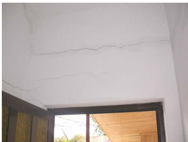
Φωτ. 34,35. Επιδείνωση προϋπαρχόντων ρηγματώσεων σε διαχωριστικούς τοίχους σε μονώροφο κτίριο από ο/σ στο Καλοχώρι.
