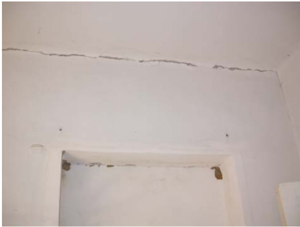
Φωτ.26,27. Οικισμός Αγ. Ανδρέας Δήμου Αίτπειας. Ρηγματώσεις σε δώροφο κτίριο από τοιχοποιία.
