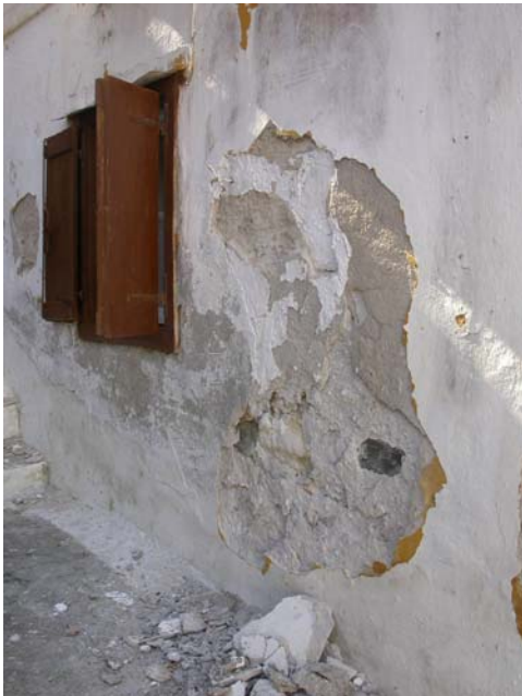
Φωτ.13,14. Πτώση σοφάδων και προυπάρχουσα ρηγμάτωση τοιχοποιίας στην Κορώνη.
