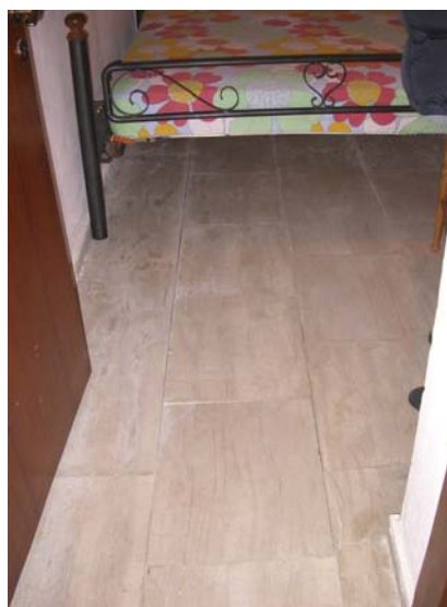
Φωτ. 36,37. Επιδείνωση προϋπαρχόντων ρηγματώσεων σε διαχωριστικούς τοίχους σε μονώροφο κτίριο από ο/σ στο Καλοχώρι. Αστοχία των πλακιδίων του πατώματος.
