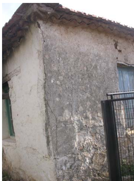
Φωτ. 42,43. Οικισμός Χρυσοκελαριά Δήμου Κορώνης. Ρηγματώσεις σε μονώροφο κτίριο από τοιχοποιία.
