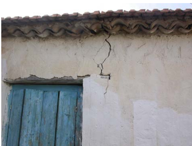
Φωτ. 40,41. Οικισμός Χρυσοκελαριά Δήμου Κορώνης. Ρηγματώσεις σε μονώροφο κτίριο από τοιχοποιία.
