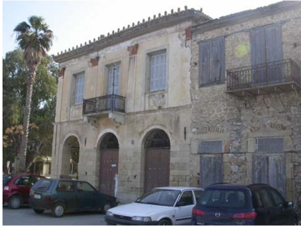
Φωτ.21,22. Αρχοντικό στην Κορώνη. Ρηγματώσεις στην τοιχοποιία.
