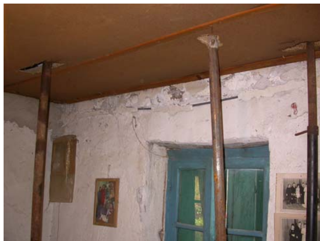
Φωτ. 38,39. Οικισμός Χρυσοκελαριά Δήμου Κορώνης. Ρηγματώσεις σε μονώροφο κτίριο από τοιχοποιία.
