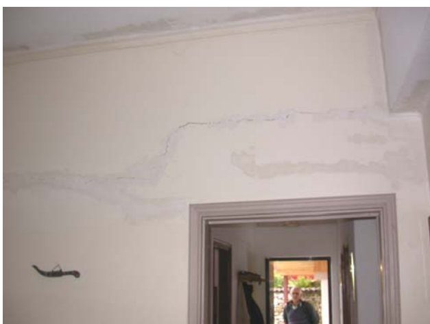
Φωτ. 32,33. Επιδείνωση προϋπαρχόντων ρηγματώσεων σε διαχωριστικούς τοίχους σε μονώροφο κτίριο από ο/σ στο Καλοχώρι.
