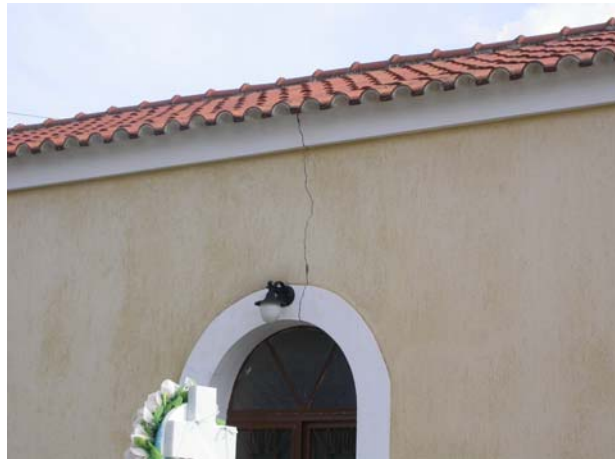
Φωτ. 44,45. Ρηγμάτωση στον Ιερό Ναό των Κοιμητηρίων μεταξύ Χαροκοπιού-Υάμεια του Δήμου Κορώνης.
