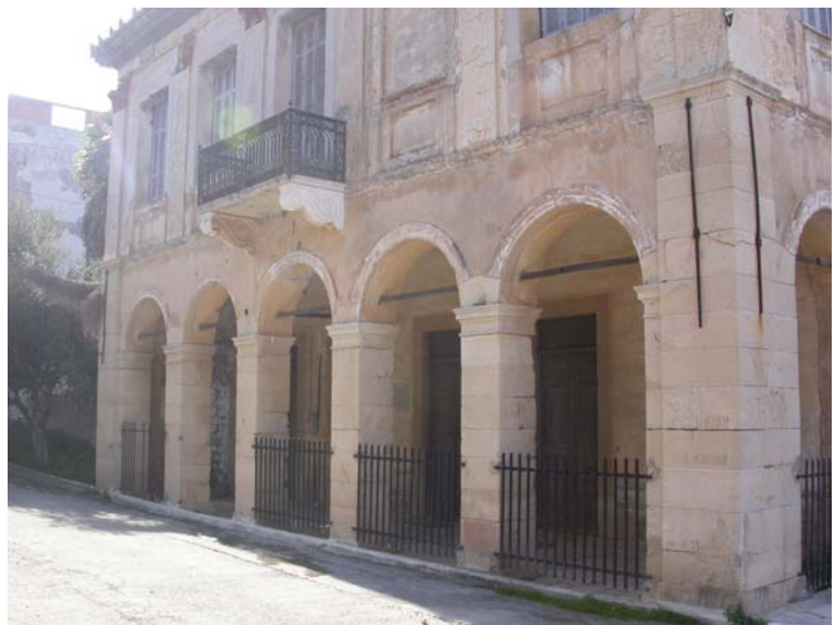
Φωτ.19,20. Αρχοντικό στην Κορώνη. Ρηγματώσεις στην τοιχοποιία.
