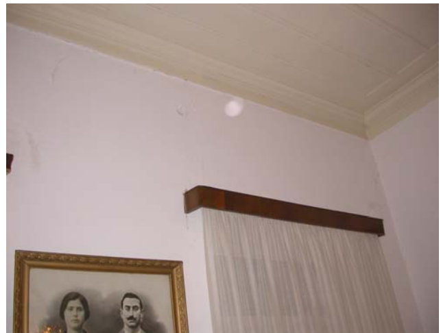
Φωτ.17,18. Αρχοντικό στην Κορώνη. Εσωτερικές ρηγματώσεις στην τοιχοποιία.
