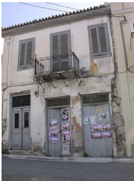
Φωτ.19,20. Αρχοντικό στην Κορώνη. Ρηγματώσεις στην τοιχοποιία.
