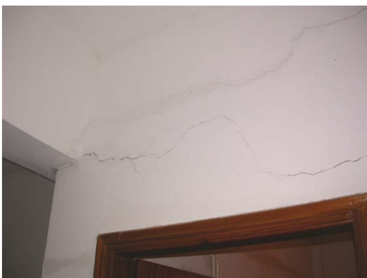
Φωτ. 36,37. Επιδείνωση προϋπαρχόντων ρηγματώσεων σε διαχωριστικούς τοίχους σε μονώροφο κτίριο από ο/σ στο Καλοχώρι. Αστοχία των πλακιδίων του πατώματος.
