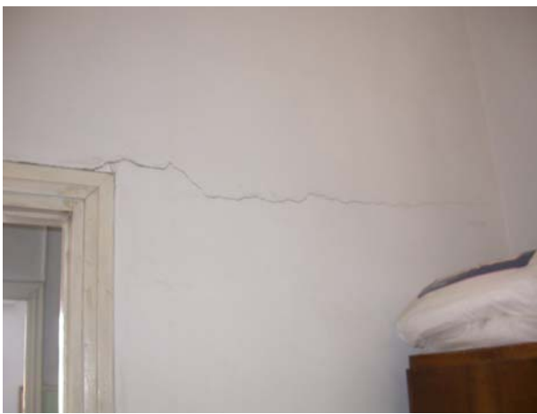
Φωτ.28,29. Οικισμός Αγ. Ανδρέας Δήμου Αίτπειας. Ρηγματώσεις σε δώροφο κτίριο από τοιχοποιία.
